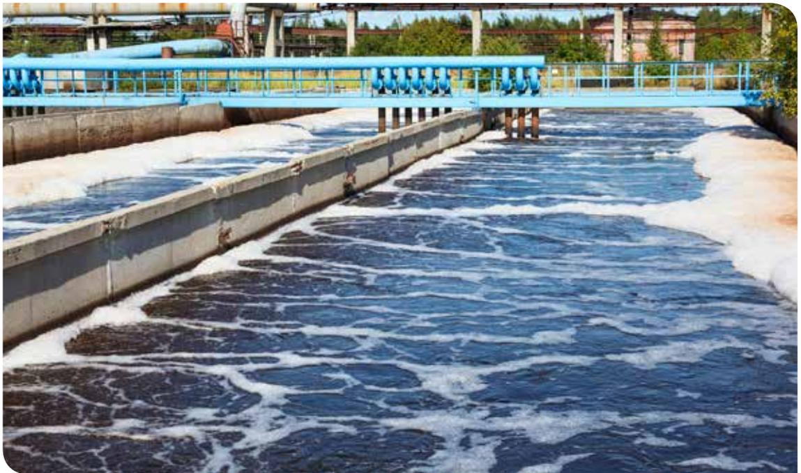
Die Nitrifikation ist Teil der biologischen Abwasserreinigung, wobei Bakterien Ammoniak zu Nitrat oxidieren. Aufgrund ihrer hohen Empfindlichkeit können diese sehr schnell durch Frachtspitzen geschädigt werden. Toxizität ist der häufigste Grund für Ausfälle dieses wichtigen Prozesses.
